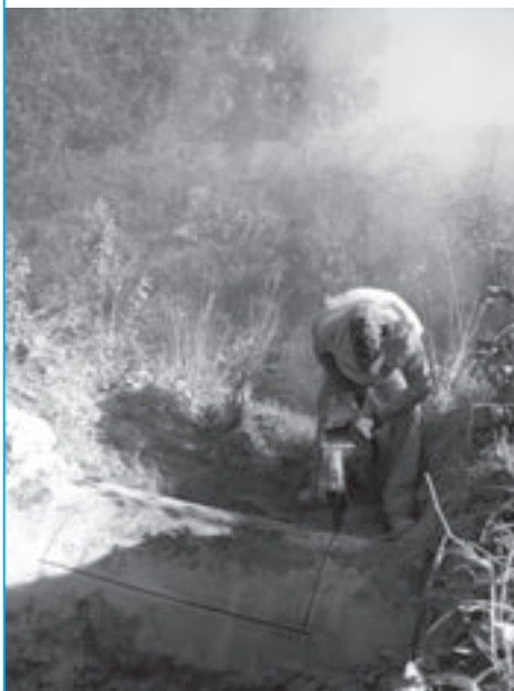
De aanleg van een 'overstort' aan de Moorbeek.
